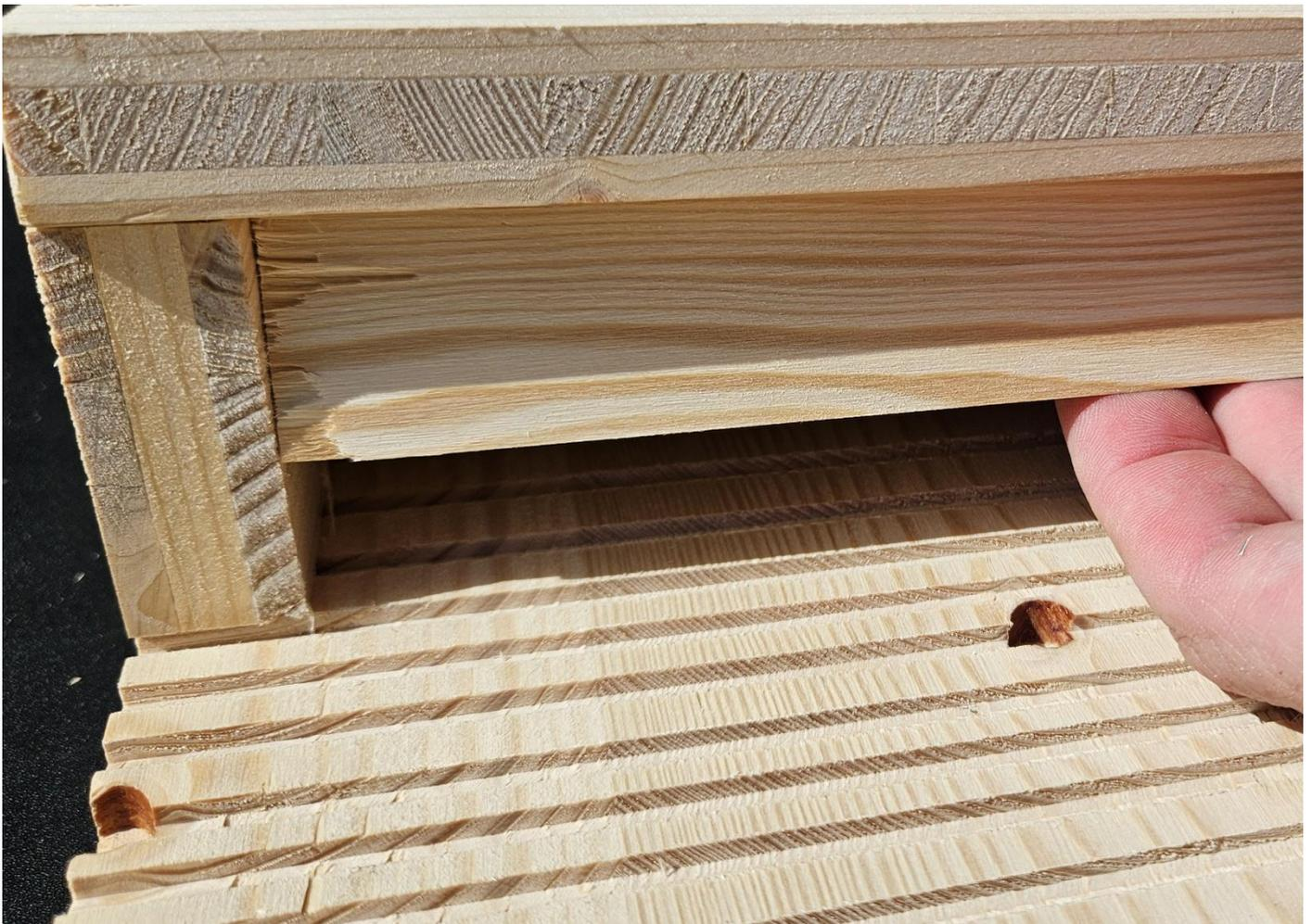
**Einflugleiste montieren – angeschrägt anbringen, um Verdreckung zu vermeiden am Einflugsplatt**
