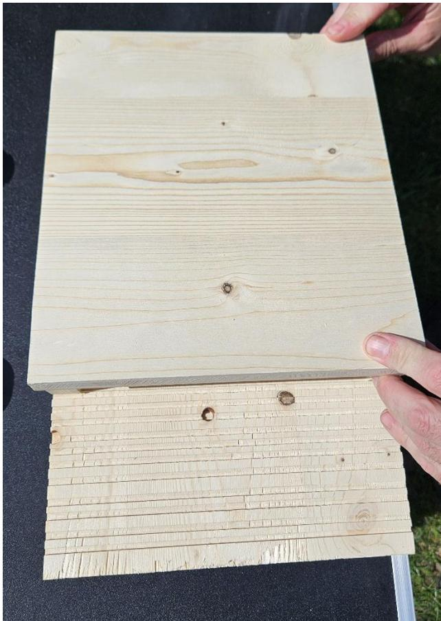
**Vorderwand/Blende anbringen** - Vorderwand befestigen, oben bündig für das Dach
