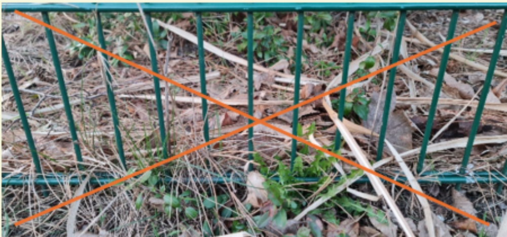
FALSCH (direkt auf Boden angebracht)
