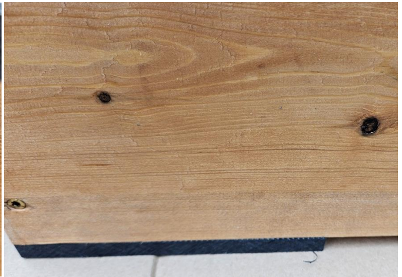
Dachverschluß zum Schutz vor Waschbär, damit es nicht angehoben werden kann Schutz vor Feuchtigkeit am Boden als Erhöhung unter dem Boden witterungsbeständige Platten
