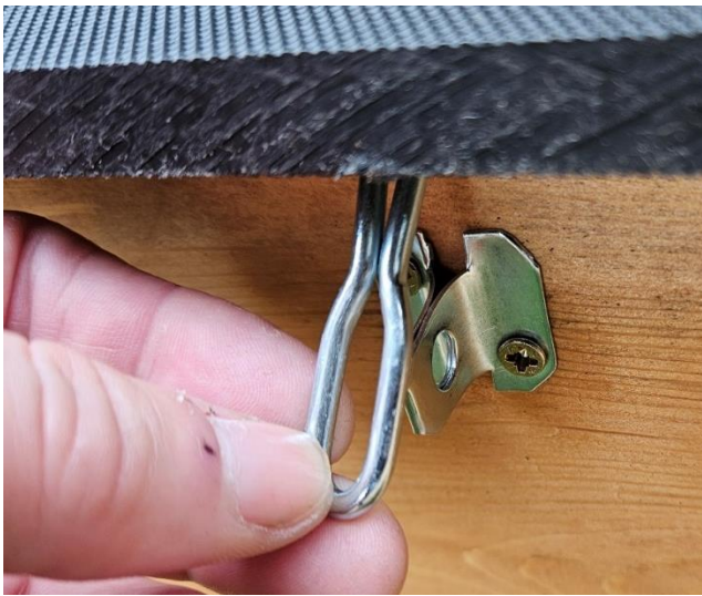
Dachverschluß zum Schutz vor Waschbär, damit es nicht angehoben werden kann Schutz vor Feuchtigkeit am Boden als Erhöhung unter dem Boden witterungsbeständige Platten
